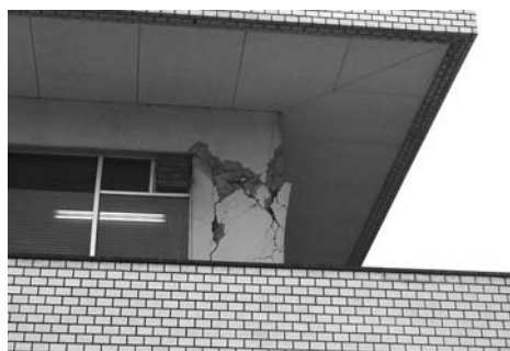
旧外来臨床研究棟の4階部分。柱に大きな亀裂が見られる。立入禁止措置に伴い同研究棟内の麻酔科学分野、腎臓内科学分野、脳神経外科学分野は医局移転を余儀なくされた。
